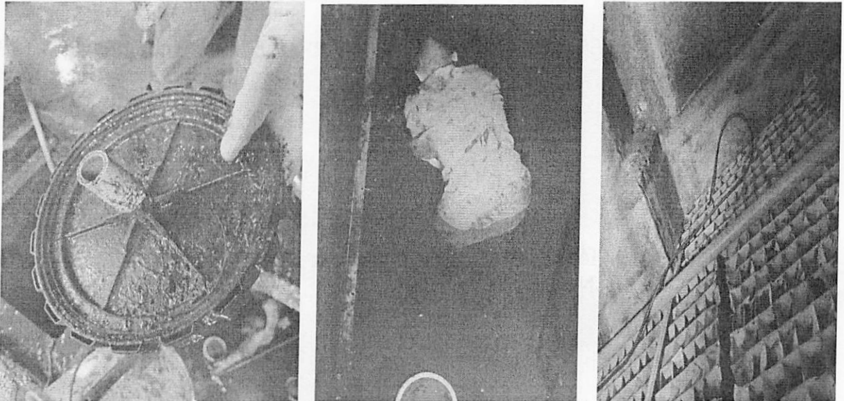
Kiểm tra thay đĩa phân phối khí hư hỏng và vệ sinh tấm lắng lamen định kỳ
