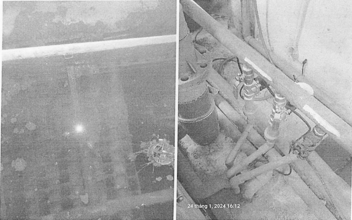
Vệ sinh bùn nổi bề lắng và cân chỉnh thu bùn bề mặt bề lắng
